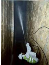
ทำการฉีดล้างถังน้ำภายในและทำการวัด
