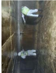
ทำการฉีดล้างถังน้ำภายในและทำการวัด
