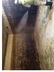
ทำการฉีดล้างถังน้ำภายในและทำการวัด
